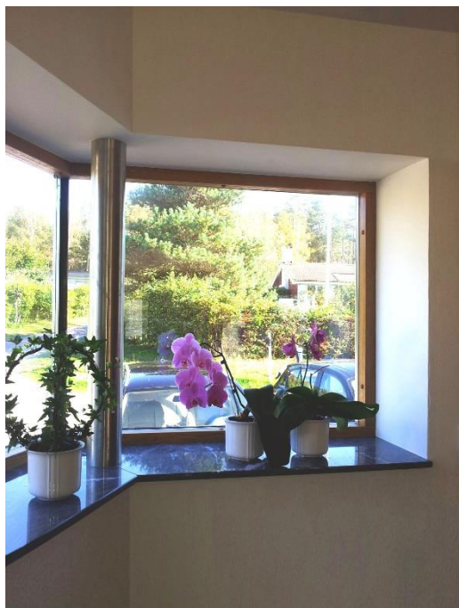
Billede 1 og 2. Hjørneløsning med synlig søjle/stolpe med glas-til-glas hjørnevindue.
